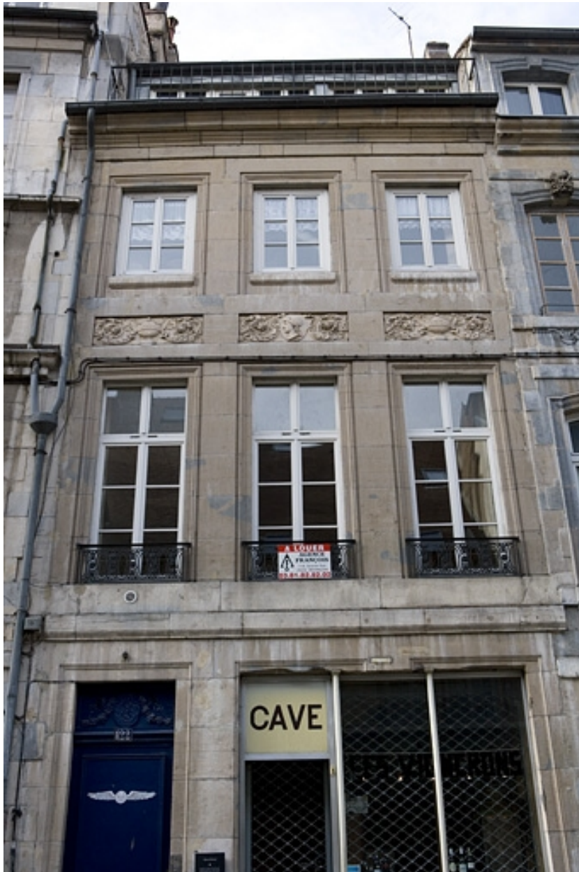
Vue d'ensemble de la façade antérieure : de face.
