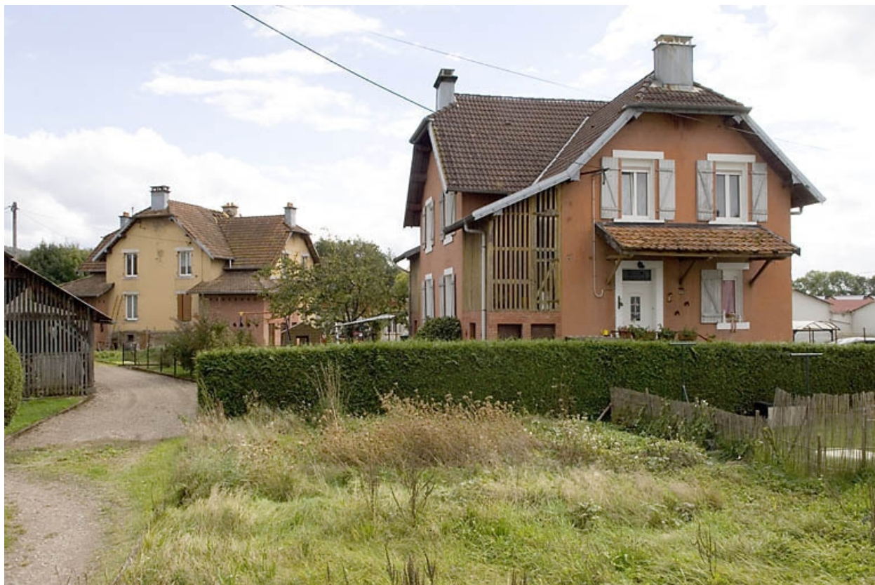
Maisons ouvrières à quatre logements.
