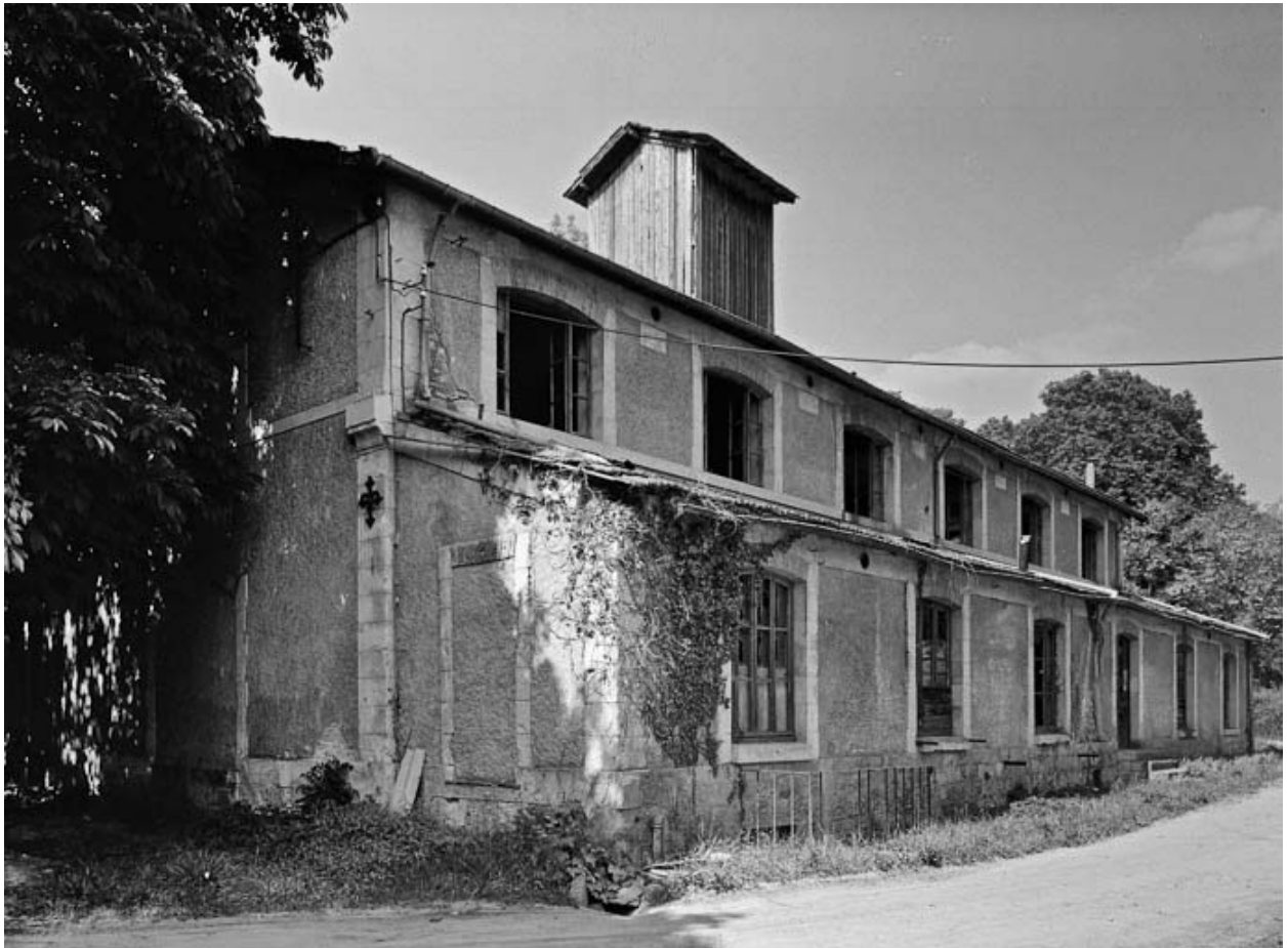
État en 1984, vue depuis le sud-ouest.
