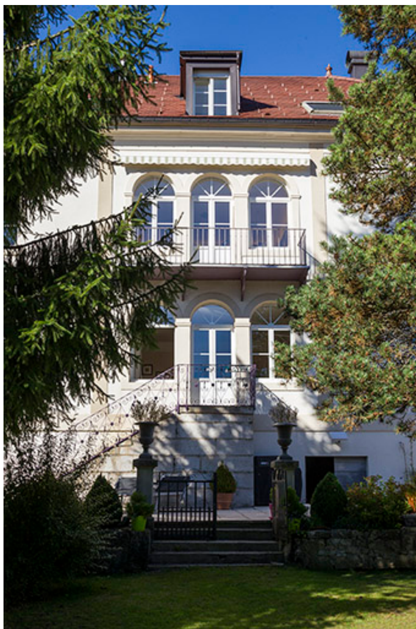
Façade postérieure : travée centrale.
