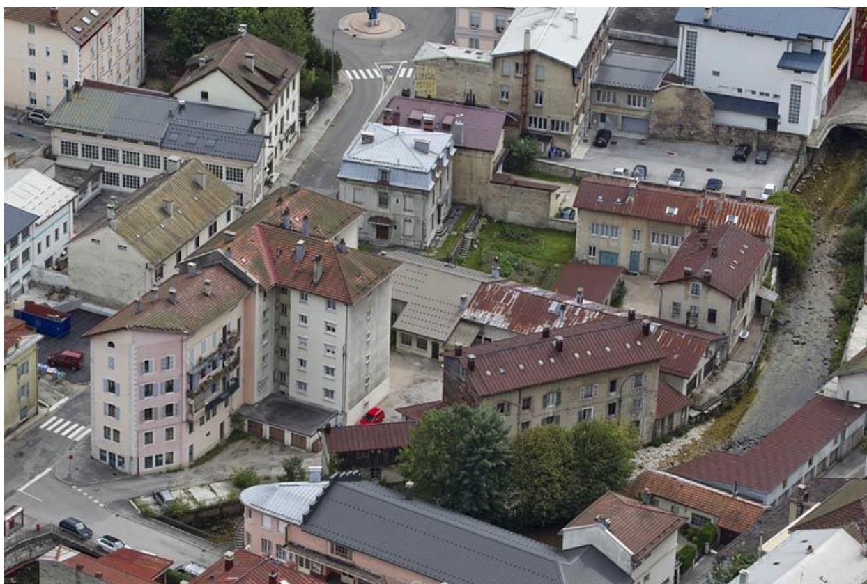
Morez : usine d'horlogerie Paul Odobey Fils puis Odo, 1 à 13 cour Paul Odobey.
