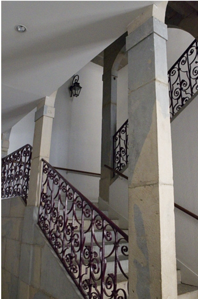
Maison entre les deux cours : détail des premières volées de l'escalier rampe sur rampe.
