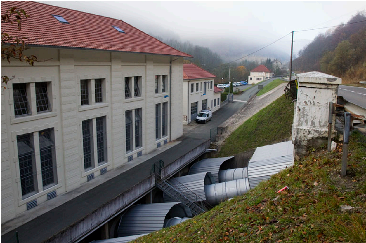
Centrale, de trois quarts gauche, avec les conduites forcées.
