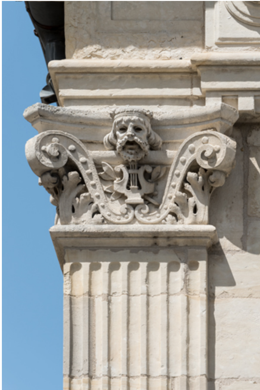
1er pilastre à l'étage carré (à gauche), chapiteau : tête sur la face avant.
