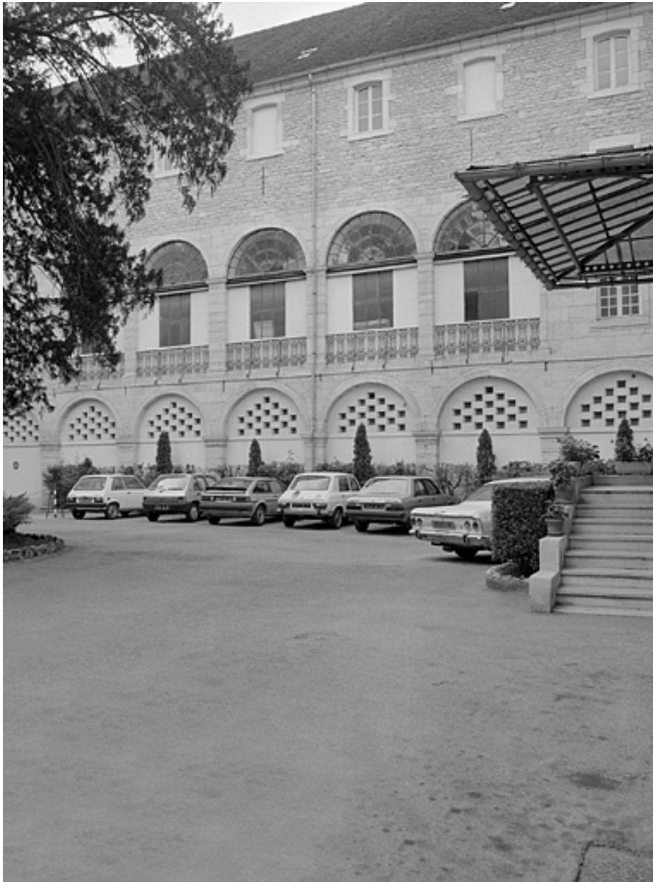
Bâtiments conventuels, cour intérieure, façade nord.
