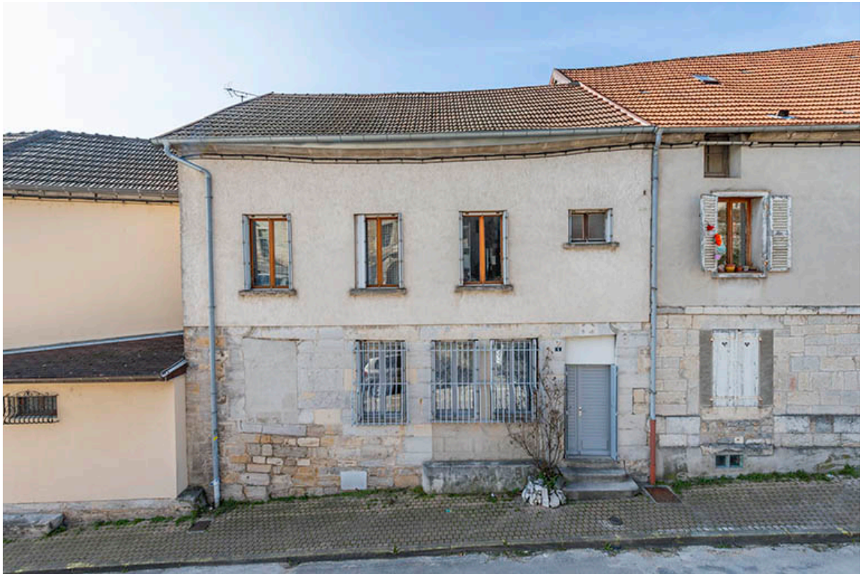
Façade est (rue Charles David).
