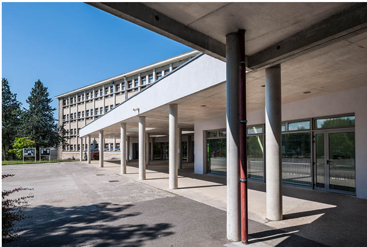
Liaison entre bâtiments : détail.
