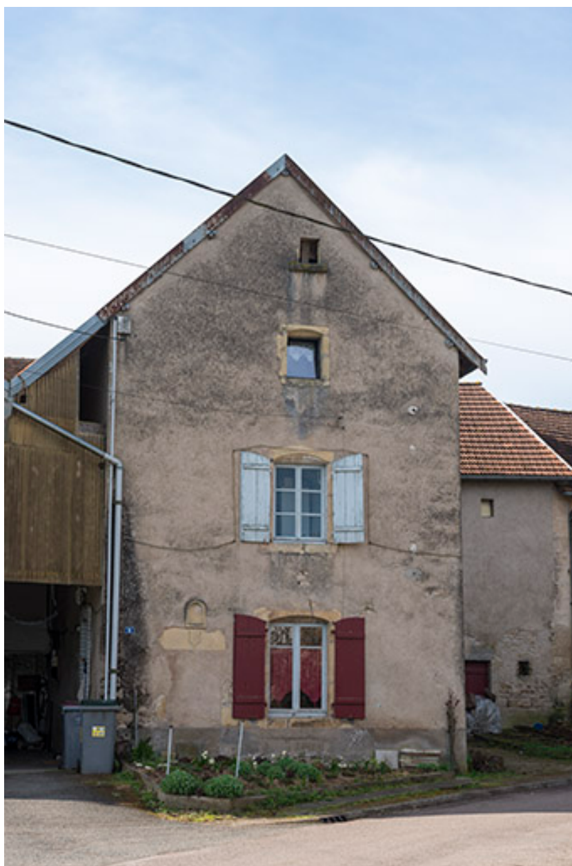
Détail sur les baies du mur pignon.
