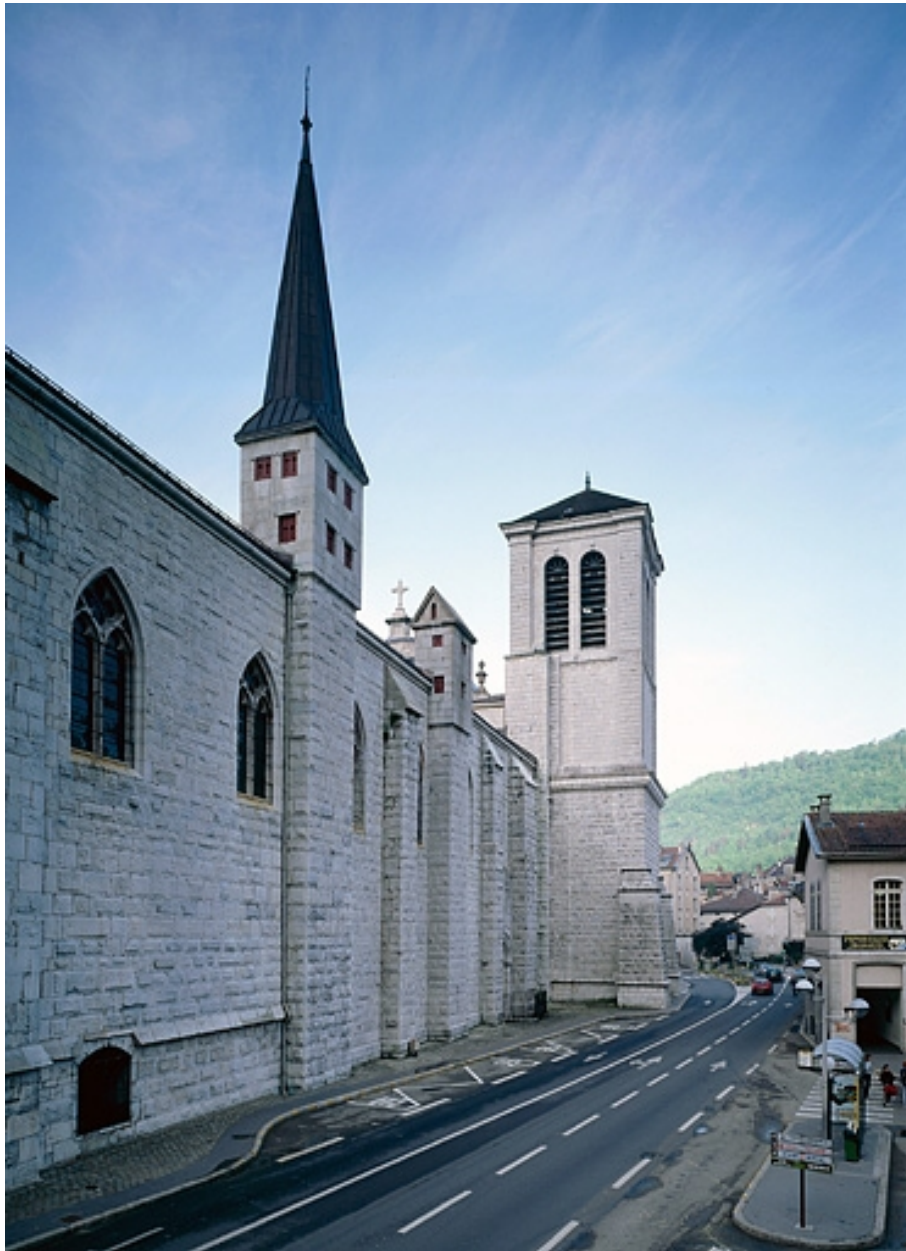
Vue du flanc nord vers l'ouest.
