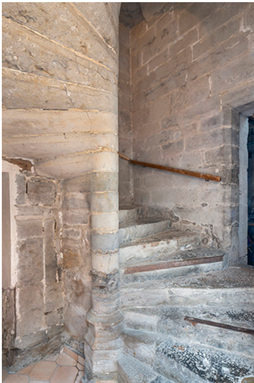
Escalier en vis (bâtiment sur rue).
