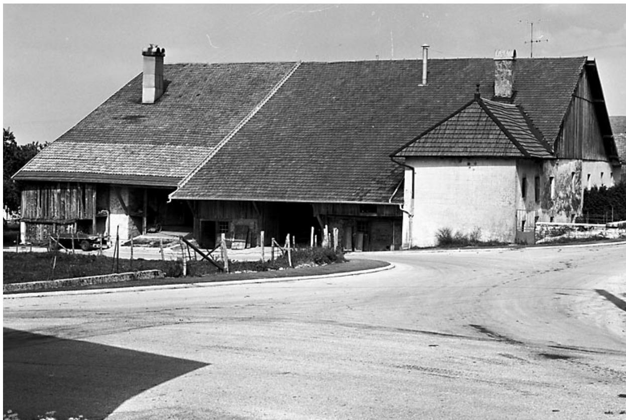
Ferme située 35-37 rue des Châteaux d'Eau : vue d'ensemble.
