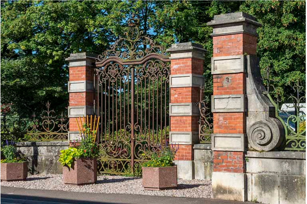
Clôture (grille) sur la rue Armand Paulmard.
