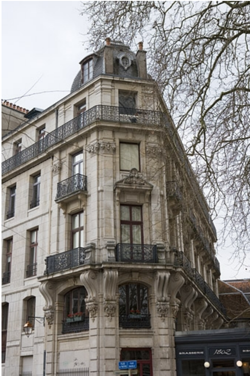
Vue d'ensemble de l'angle de l'immeuble.
