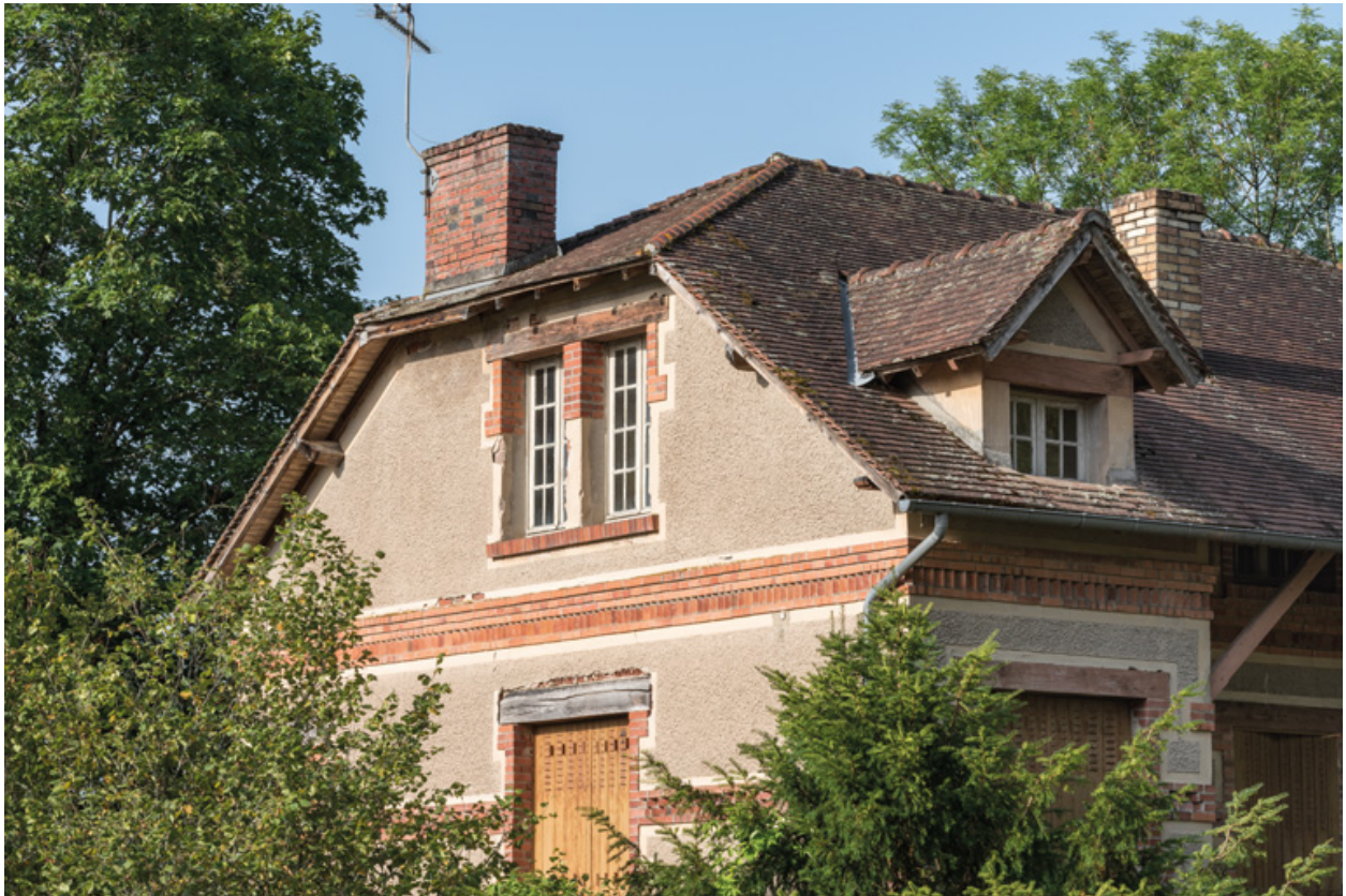
Détail de la toiture, demi-croupe et lucarne.
