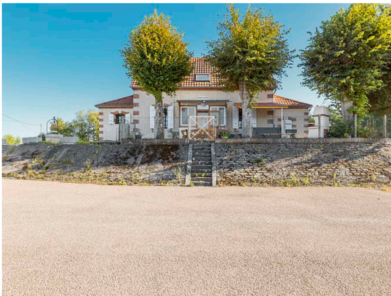
Vue d'ensemble de la maison du barragiste.
