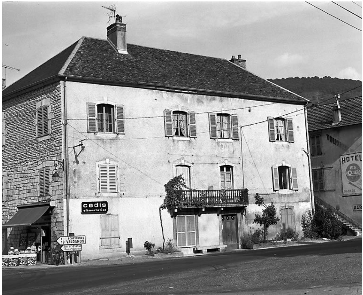
Maison située route de Pontarlier.
