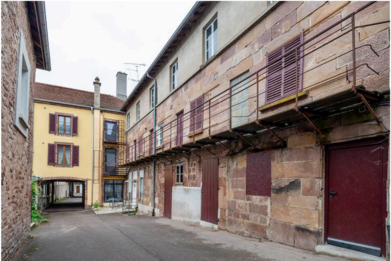
Passage entre les cours.
