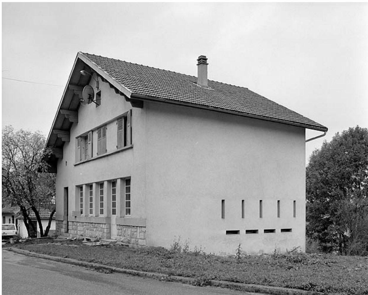
Façade antérieure et face droite.
