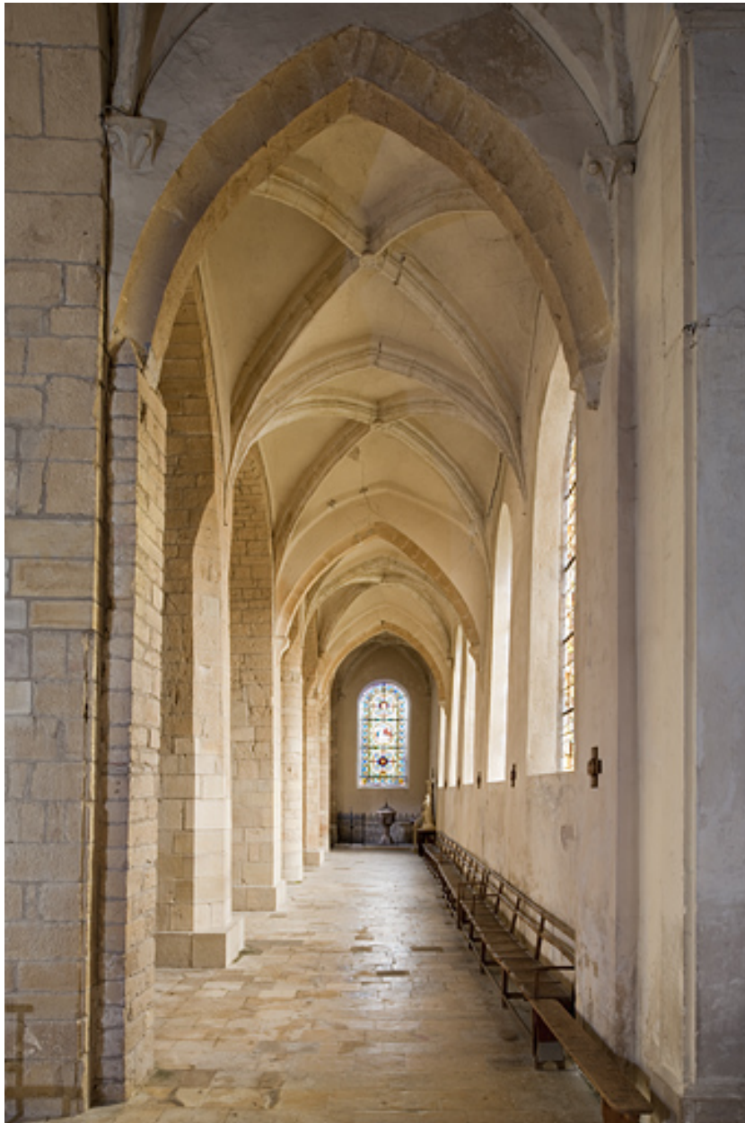
Bas-côté gauche vu depuis le transept.
