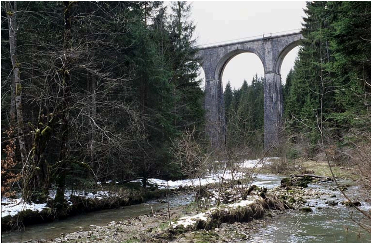
Viaduc : vue d'ensemble, depuis le fond du vallon au nord-est.
