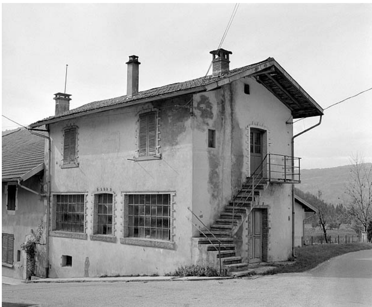
Façade longitudinale et pignon.
