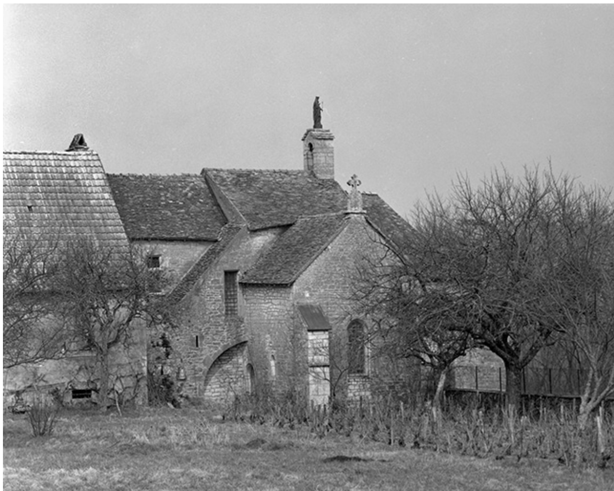
Façade latérale droite.
