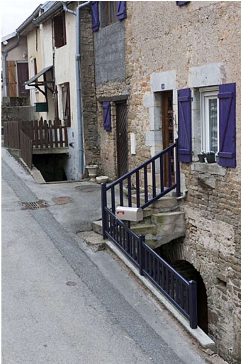
Entrées de cave des maisons aux 14 et 16 rue des Gratteris (2010 AK 110 et 111).
