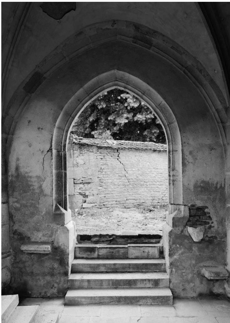
Mur gauche du porche.
