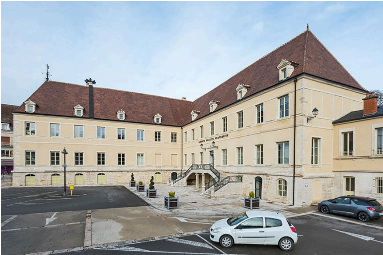
Vue d'ensemble, depuis le sud. Aile nord à gauche, aile est à droite.
