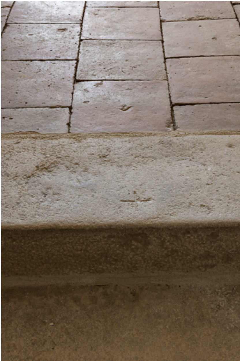
Détail de l'escalier : Marche et palier couvert de carreaux de carrelage en terre cuite
