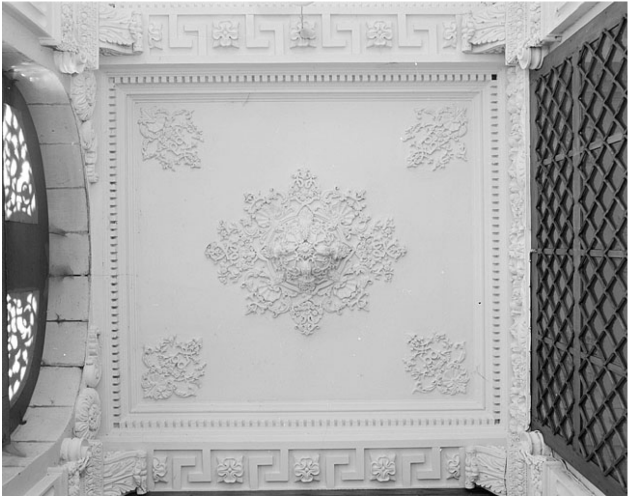
Vestibule, détail du plafond.
