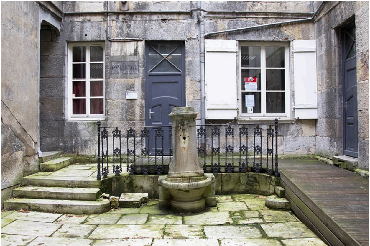
Vue du rez-de-chaussée du logis en fond de cour.
