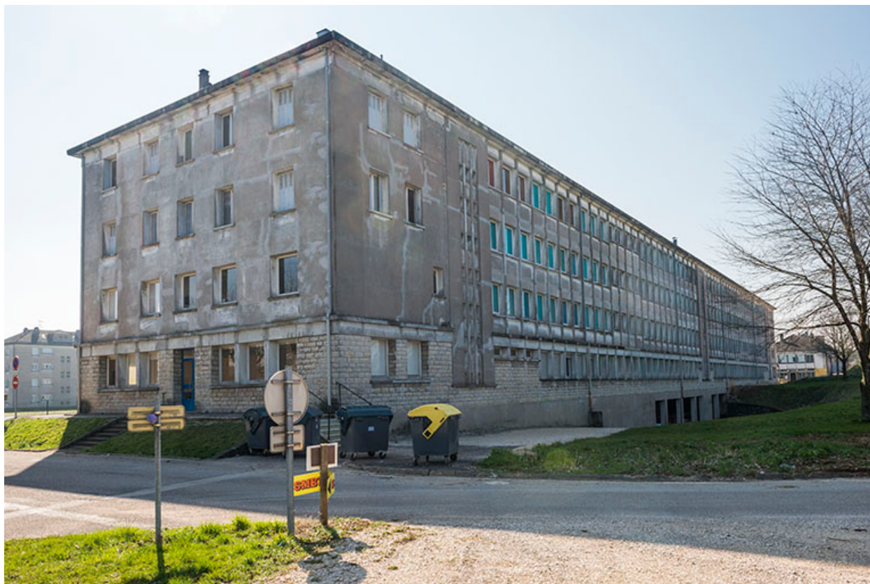
Façade postérieure de l'internat de filles.
