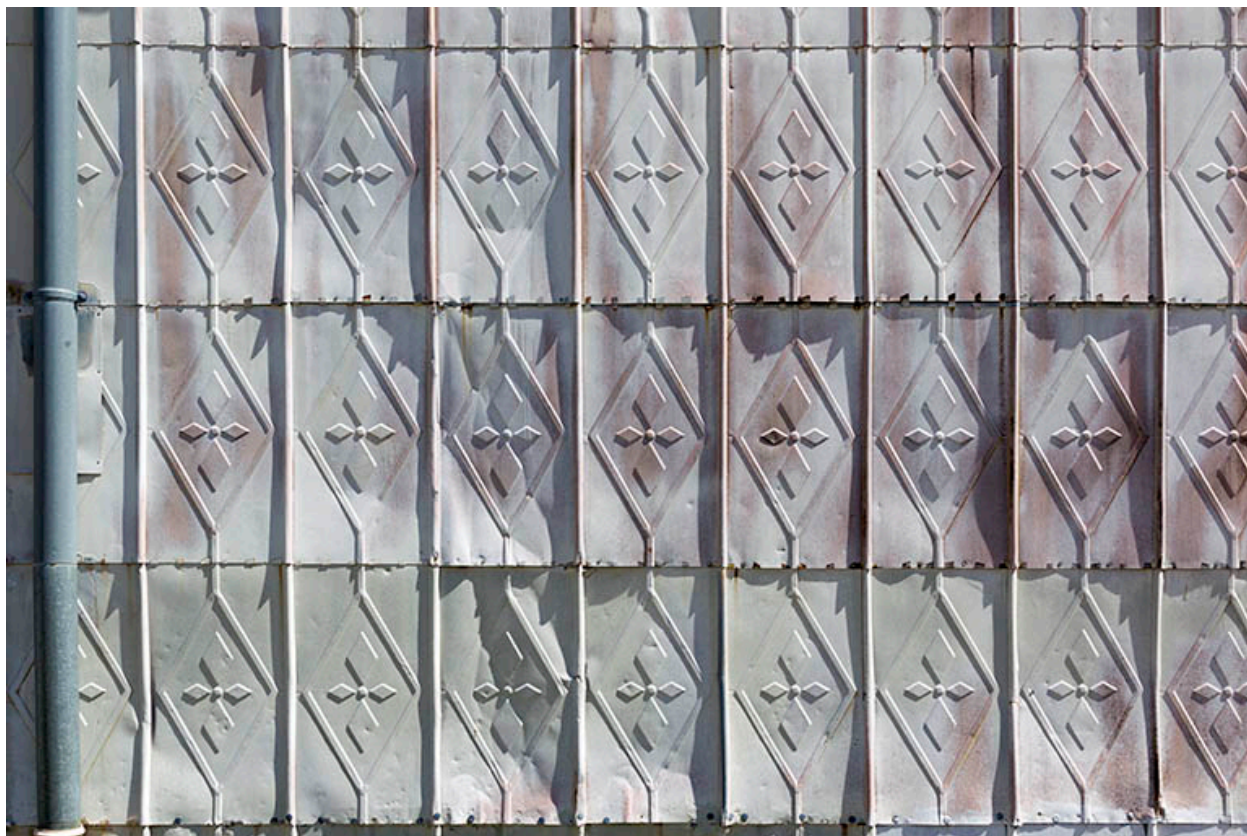
Façade latérale droite : essentage de tôle.
