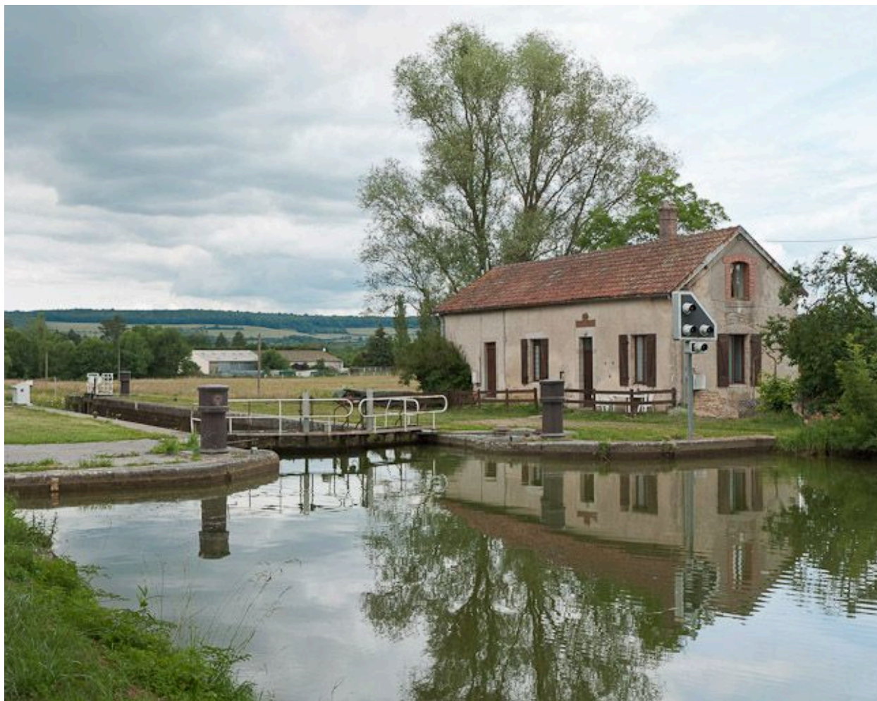
Vue d'ensemble du site d'écluse.
