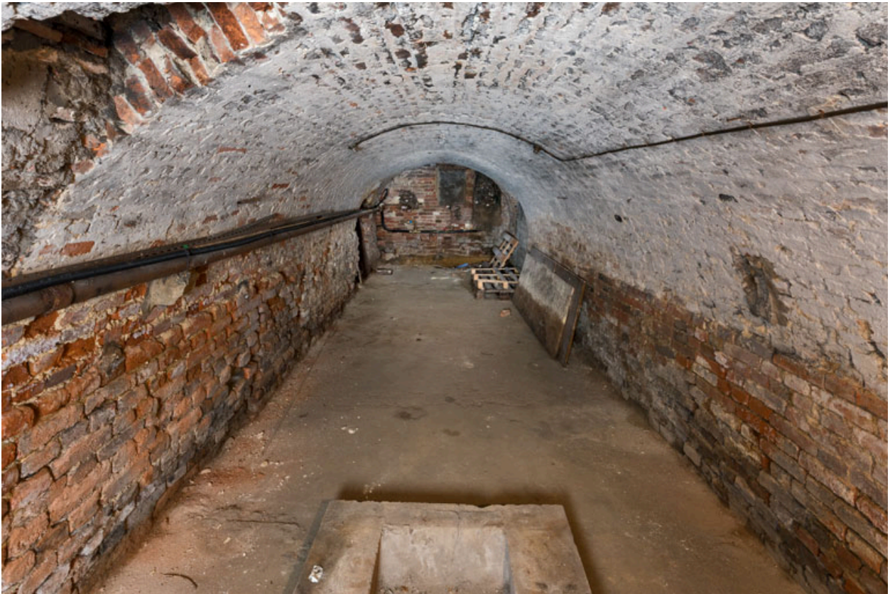
Cave voûtée au sous-sol.
