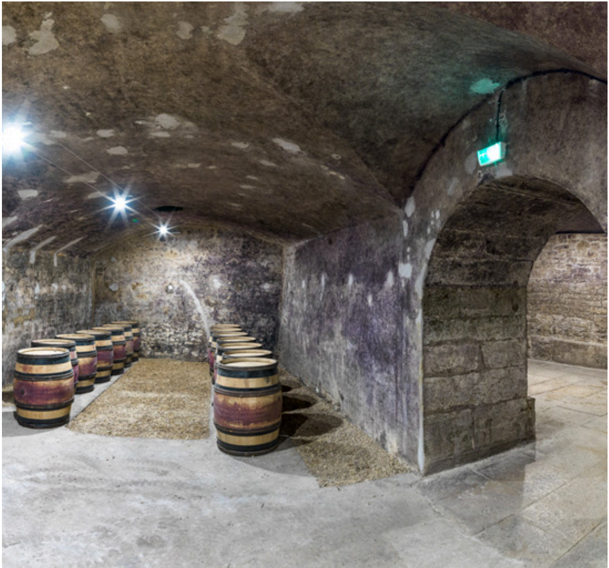
Caves, rez-de-chaussée : voûte en arc segmentaire.
