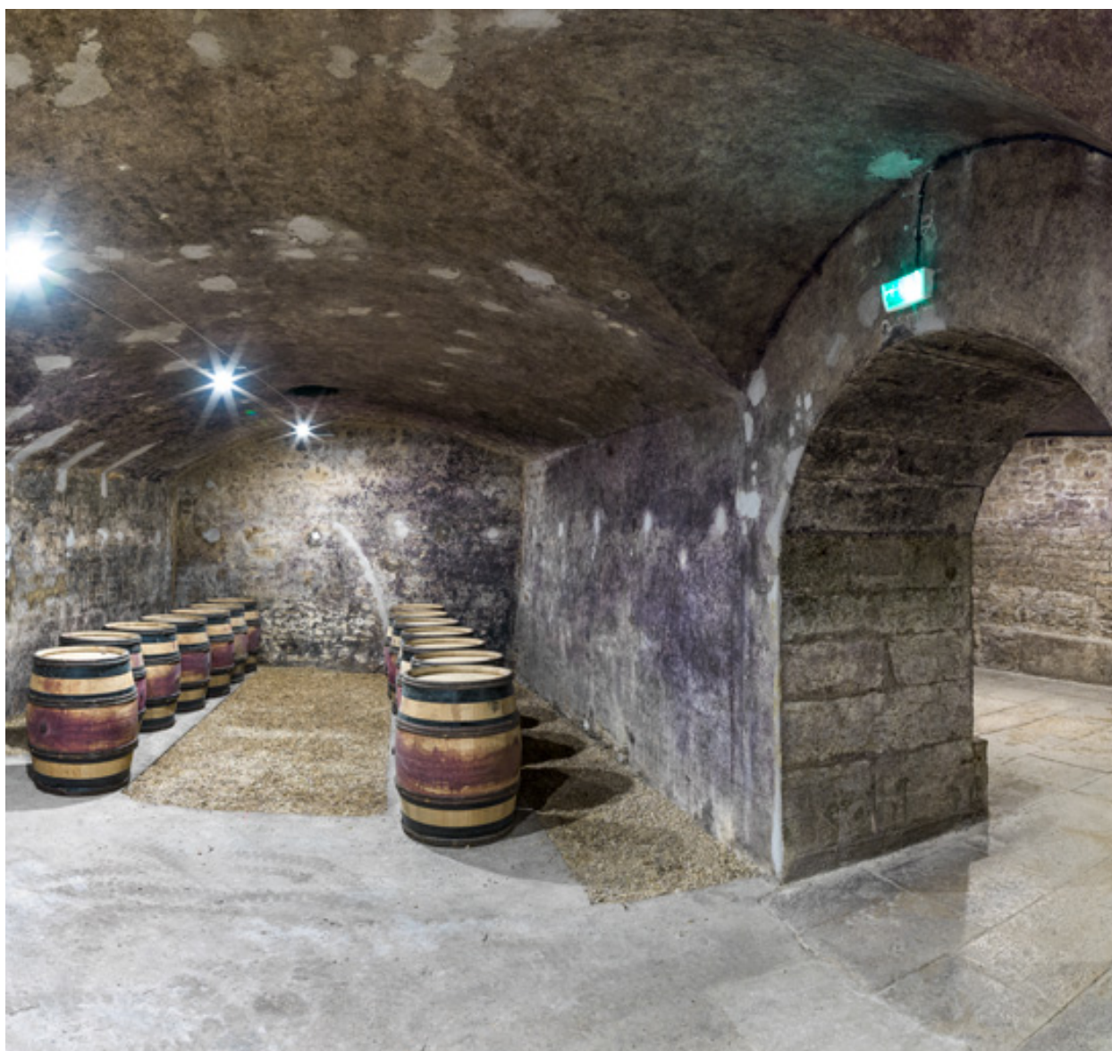
Caves, rez-de-chaussée : voûte en arc segmentaire.
