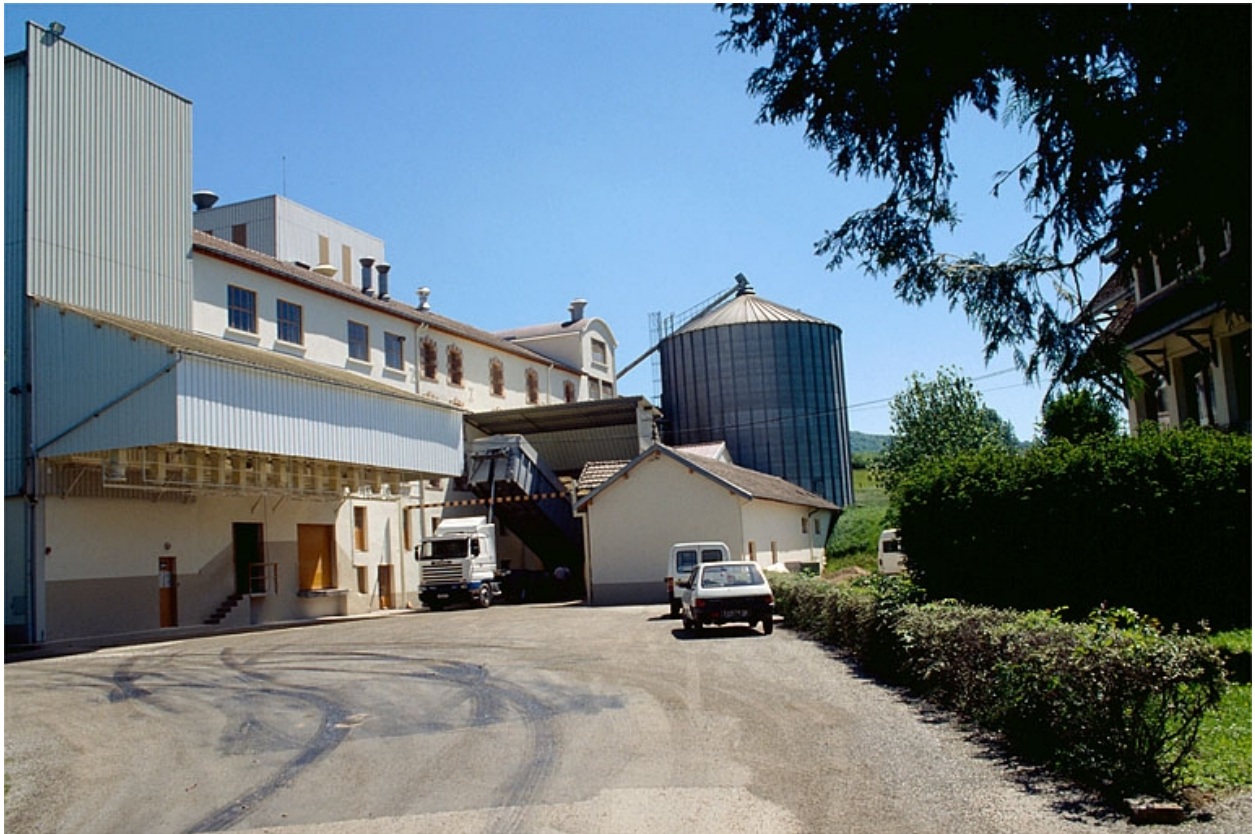
Atelier de fabrication et silos depuis l'entrée.
