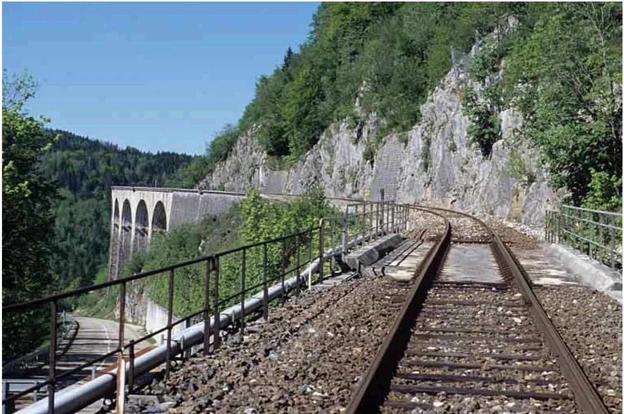
Tablier et garde-corps, depuis le côté La Cluse.
