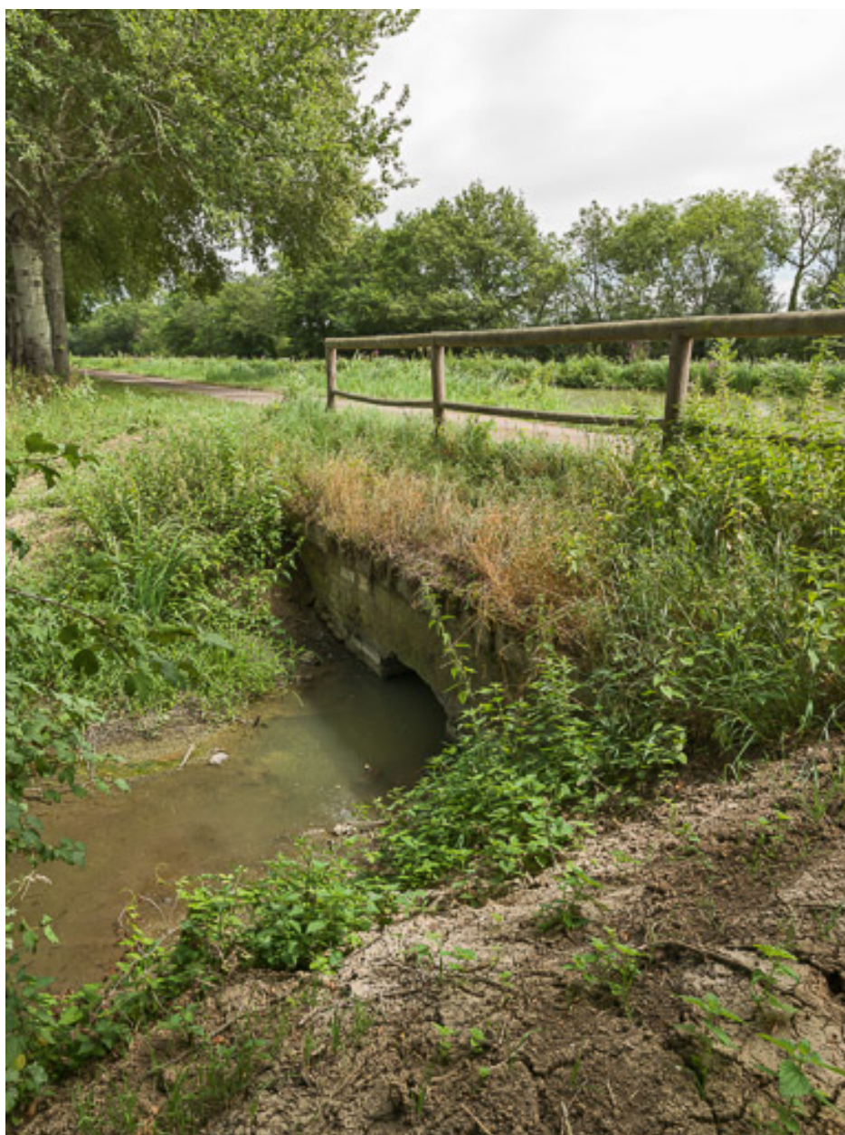
Vue de l'aqueduc.
