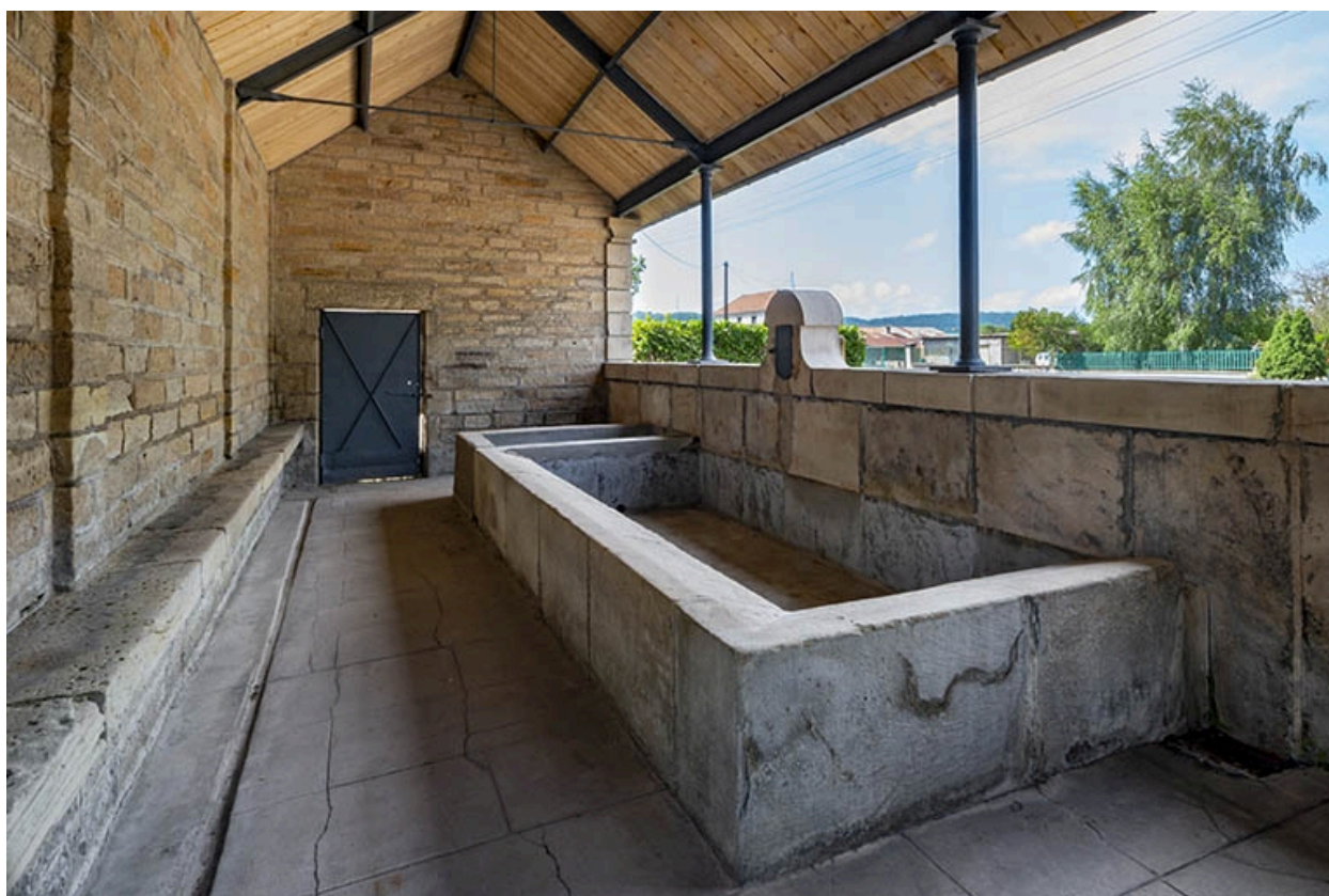
L'intérieur du lavoir, depuis le côté gauche.
