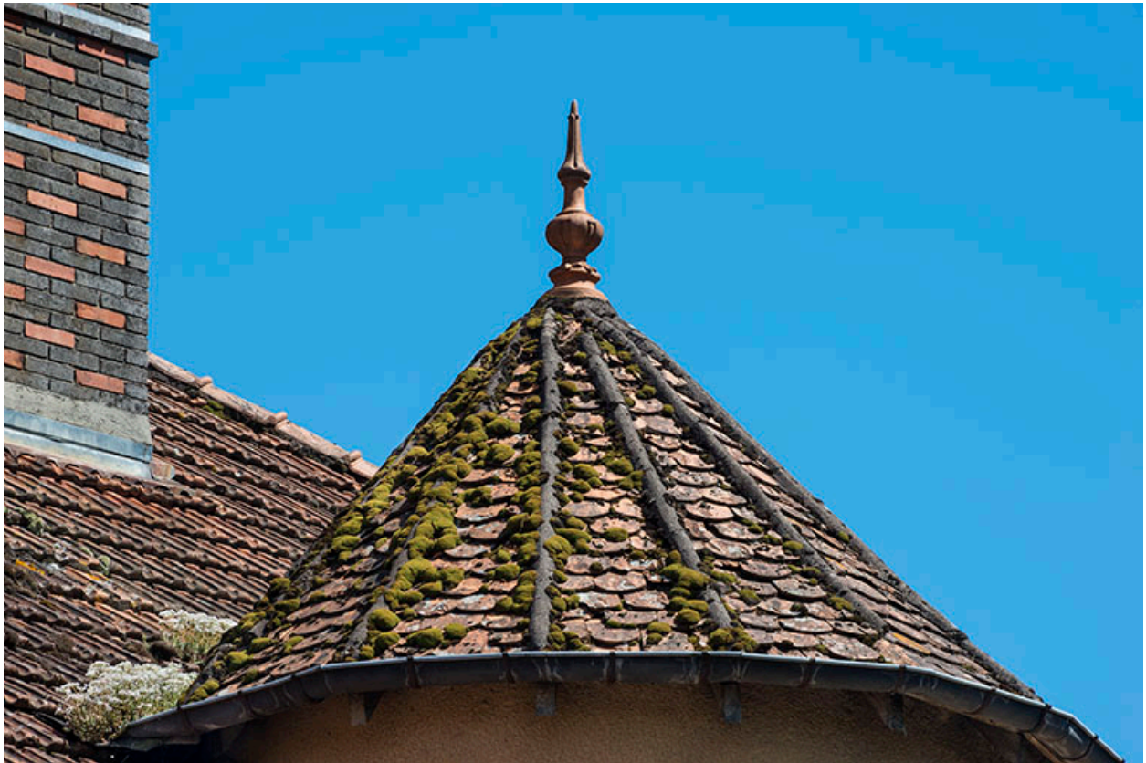
Toit conique nervuré de la tour demi-hors-œuvre.
