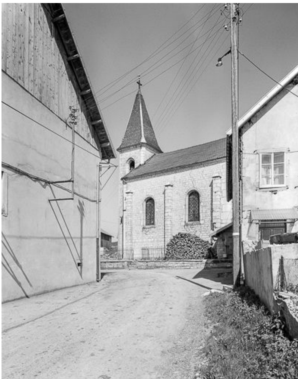
Façade latérale droite.
