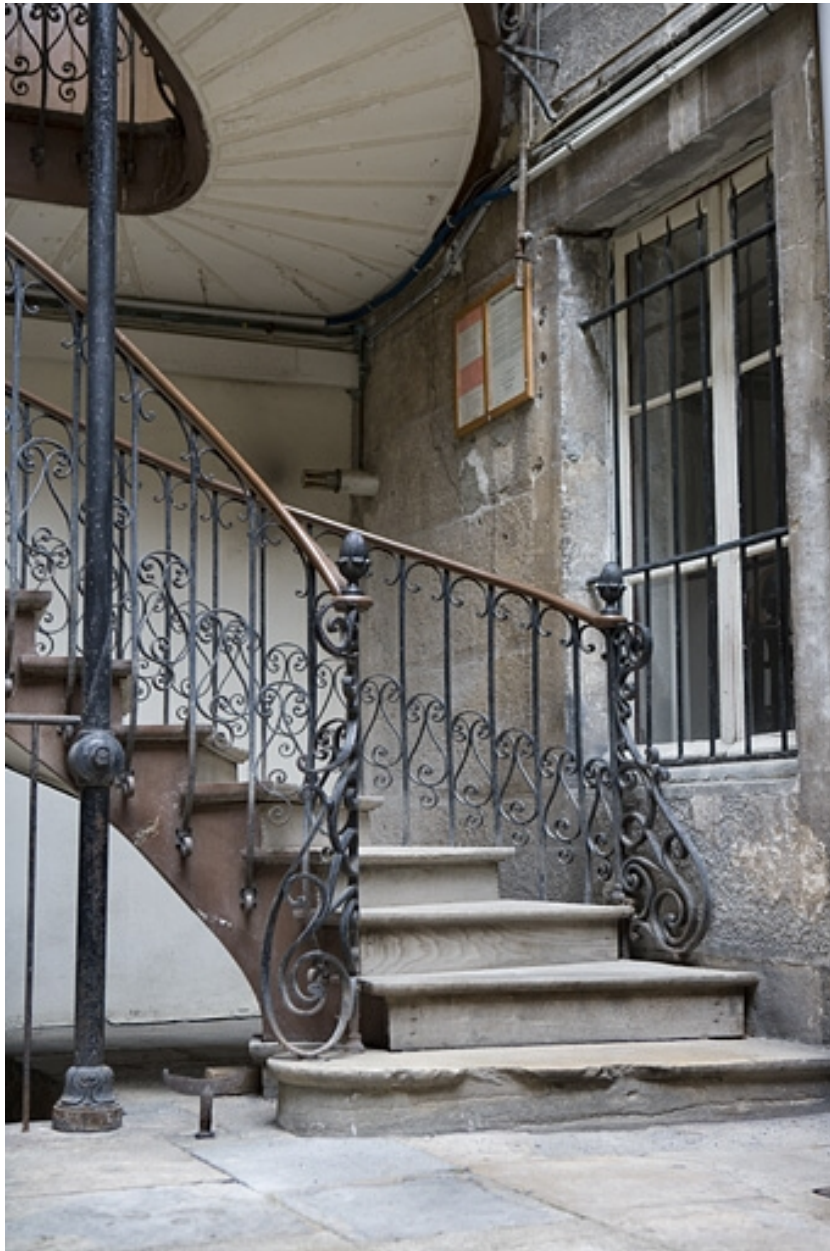
Détail du départ de l'escalier à cage ouverte, vue verticale.
