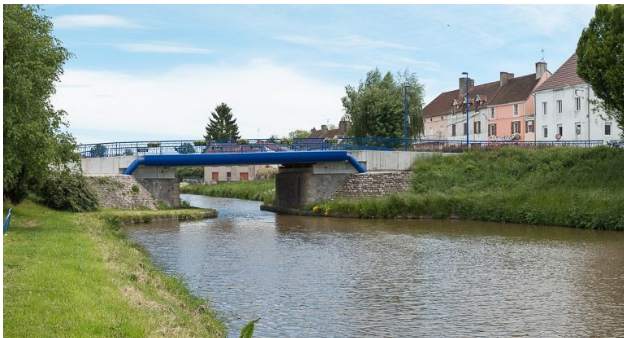
Le pont, vu d'aval.
