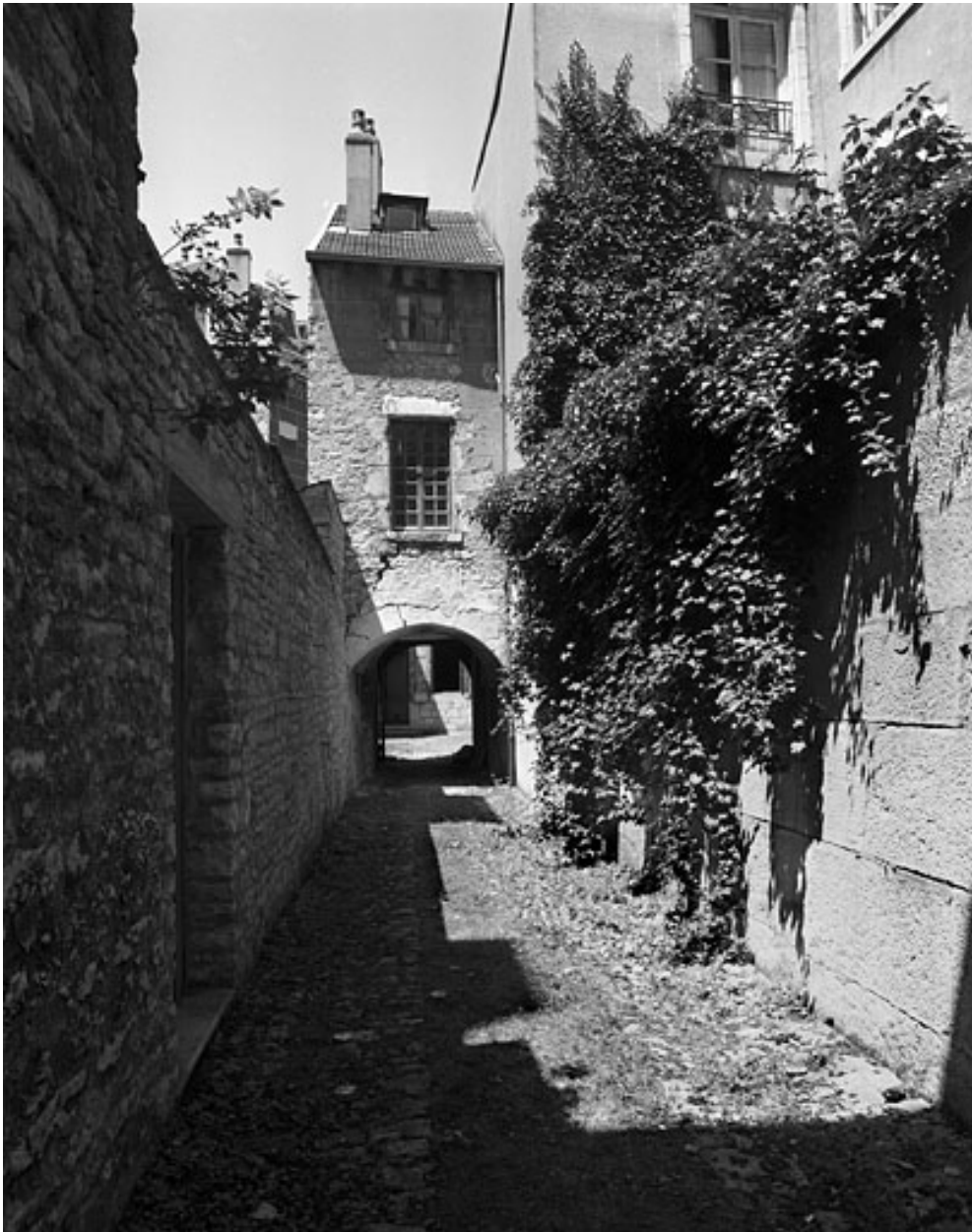
Entrée secondaire de l'édifice, rue de la Bibliothèque.
