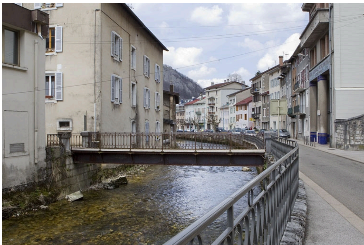
Vue d'ensemble, depuis l'amont.
