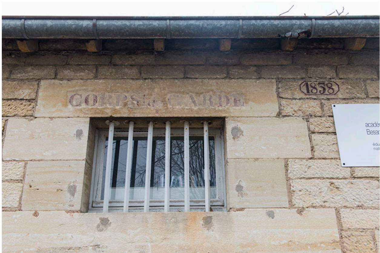
Détail de baie avec date et inscription de l'ancien corps de garde.
