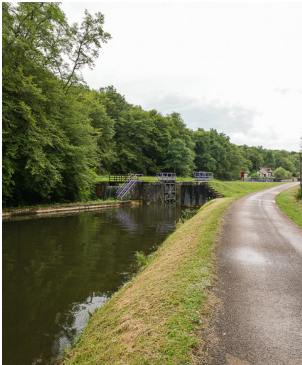
Vue du déversoir de superficie.
